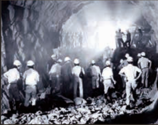
慶祝地下管道貫通的歷史時刻。攝於1977年
