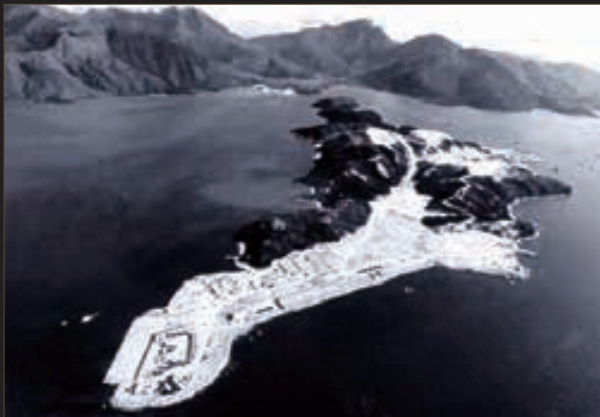
赤鱸角興建香港國際機場的工程展開。 攝於1992年
